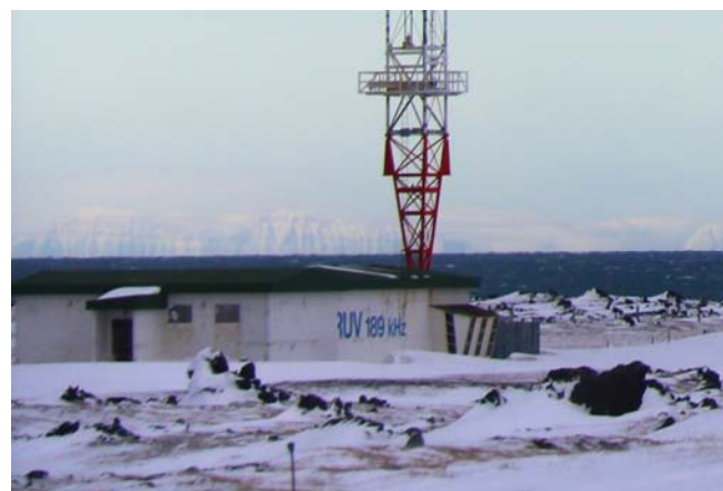
Bild 1: Fußpunkt des Stahlgittersendemastes, März 2020
